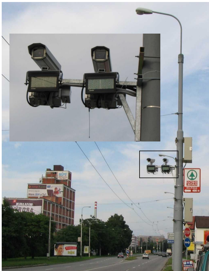
Obr. 49 Instalace systému Unicom v městské zástavbě
